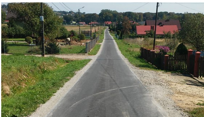
Nowa nakładka asfaltowa na drodze gminnej w Skołyszynie
