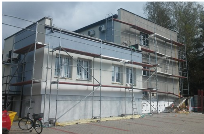
Remont budynku Gminnego Ośrodka Pomocy Społecznej
