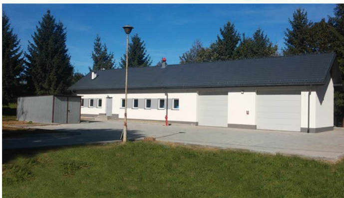
Stacja uzdatniania wody w Skołyszynie
