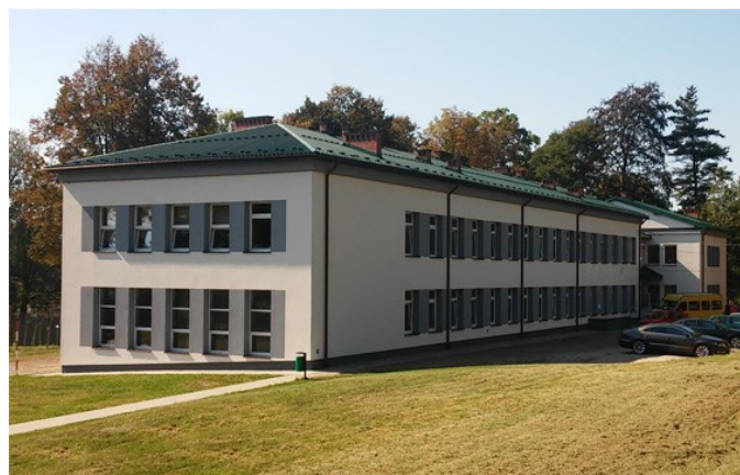
Budynek Szkoły Podstawowej w Harklowej po termomodernizacji
