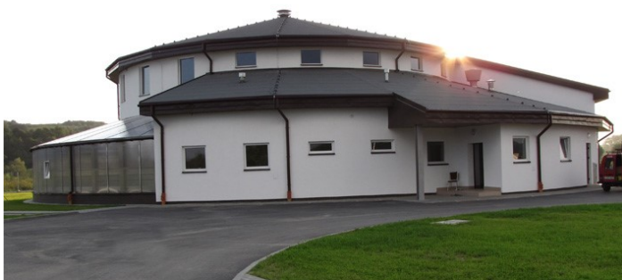
Oczyszczalnia ścieków w Przysiekach
