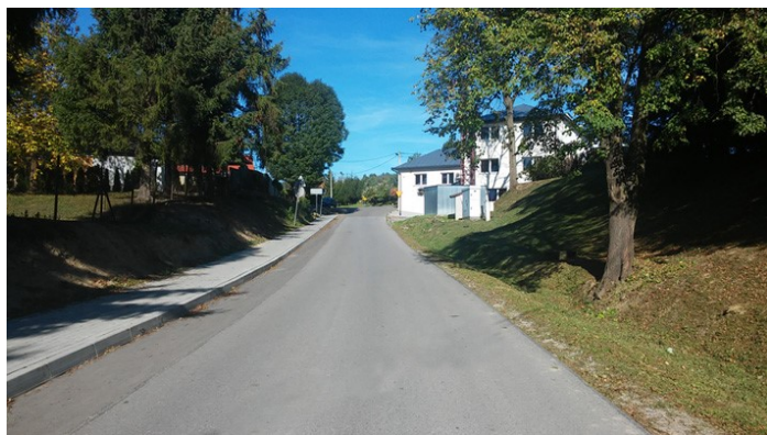
Chodnik wzdłuż drogi powiatowej w Lisowie
